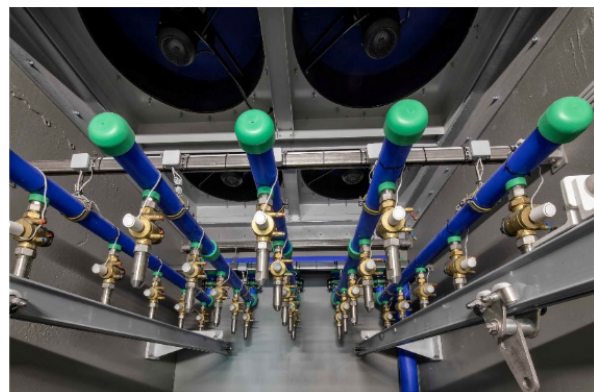
Figuur 3 Sproeisysteem in de Klimaatcascade. Fotografie: Eric Fecken
