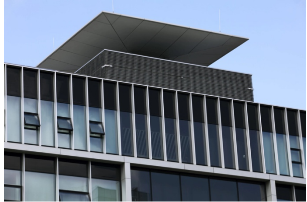
Figuur 8 Ventecdak van het Langeveld Building
