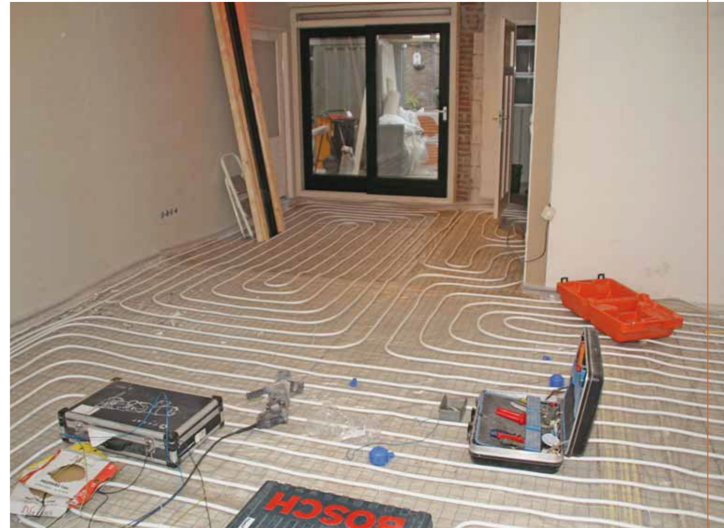
Een veel voorkomend probleem is koudeval bij natuurlijke ventilatietoevoer in combinatie met een laagtemperatuursysteem (bijvoorbeeld vloerverwarming). Ook de combinatie van grote glasoppervlakken en vloerverwarming levert problemen op in de praktijk.
