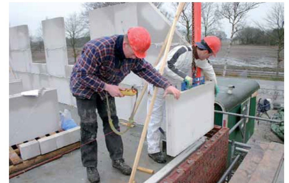
Stapelbouw met kalkzandsteen.
