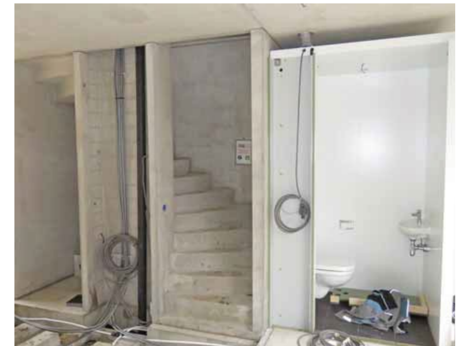
De schacht moet op een logische plaats worden gerealiseerd, dus dicht bij de toiletten, badkamer en technische ruimten. Foto: MorgenWonen van VolkerWessels.
