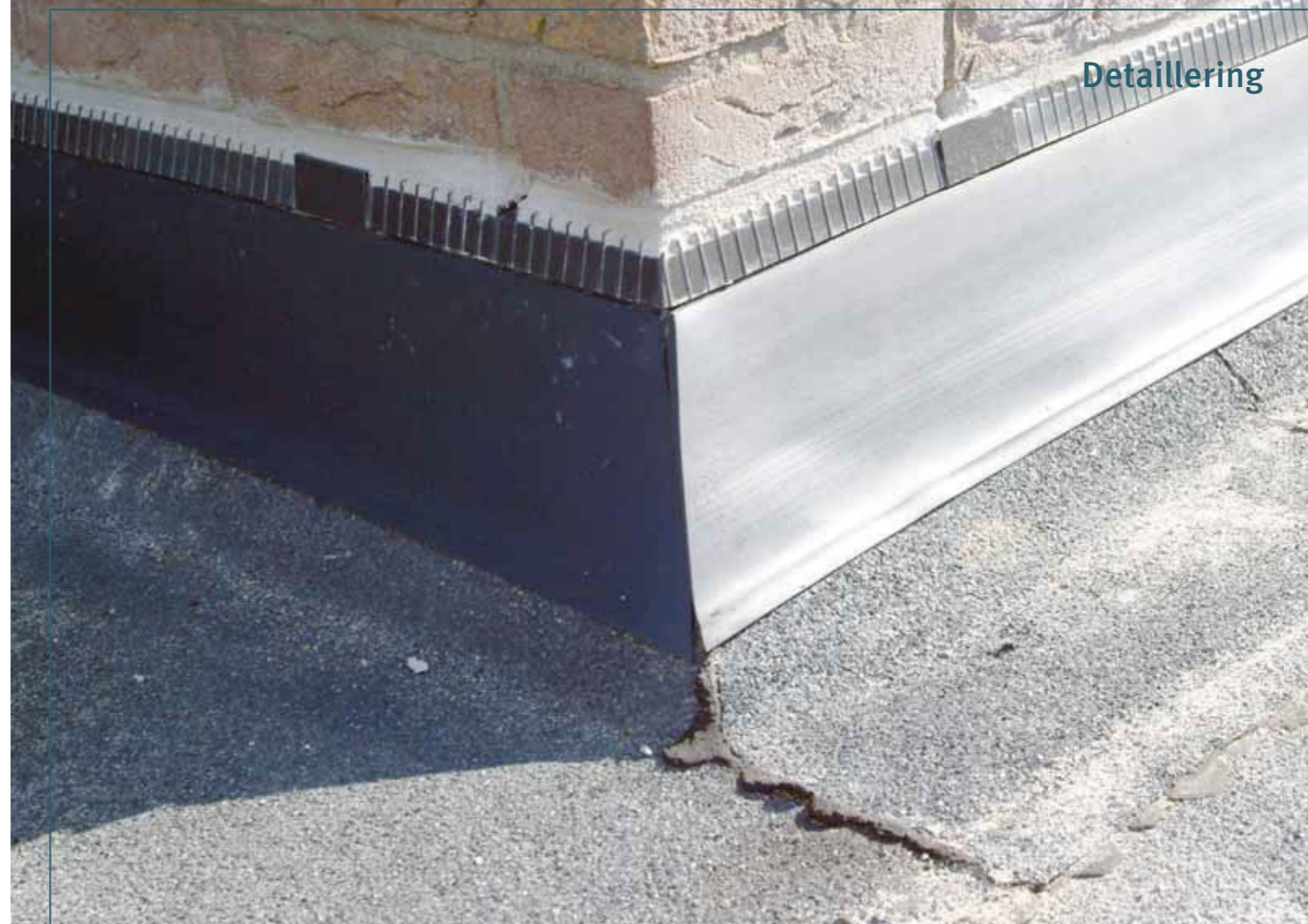
Toepassing van isolatiesteen ter voorkoming van koudebruggen. Foto: Ubbink.
