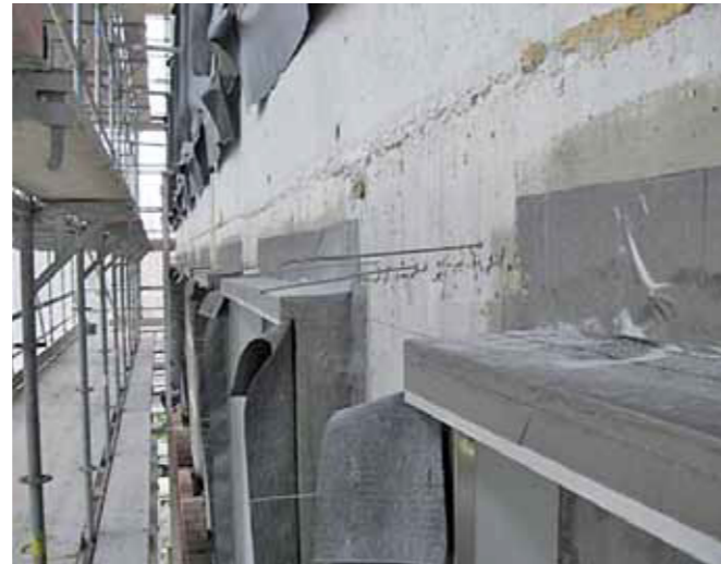
Het luchtdicht afwerken van de gebouwschil is precisiewerk. Het aantonen dat de vereiste luchtdichtheid is gerealiseerd is relatief eenvoudig mogelijk met een blowerdoortest.
