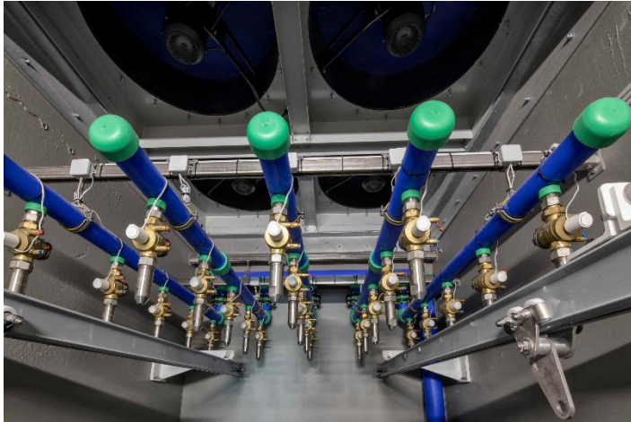
De klimaatcascade waarin de nozzles het water naar beneden sproeien
