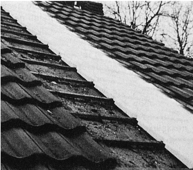
figuur 12. na-isolatie van een pannendak met speciale polystyreenschuim-elementen
