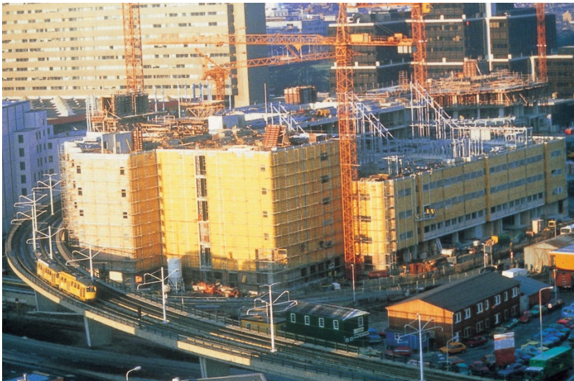
figuur 2. thermische isolatie bij de bouw van de Koninklijke Bibliotheek in Den Haag
