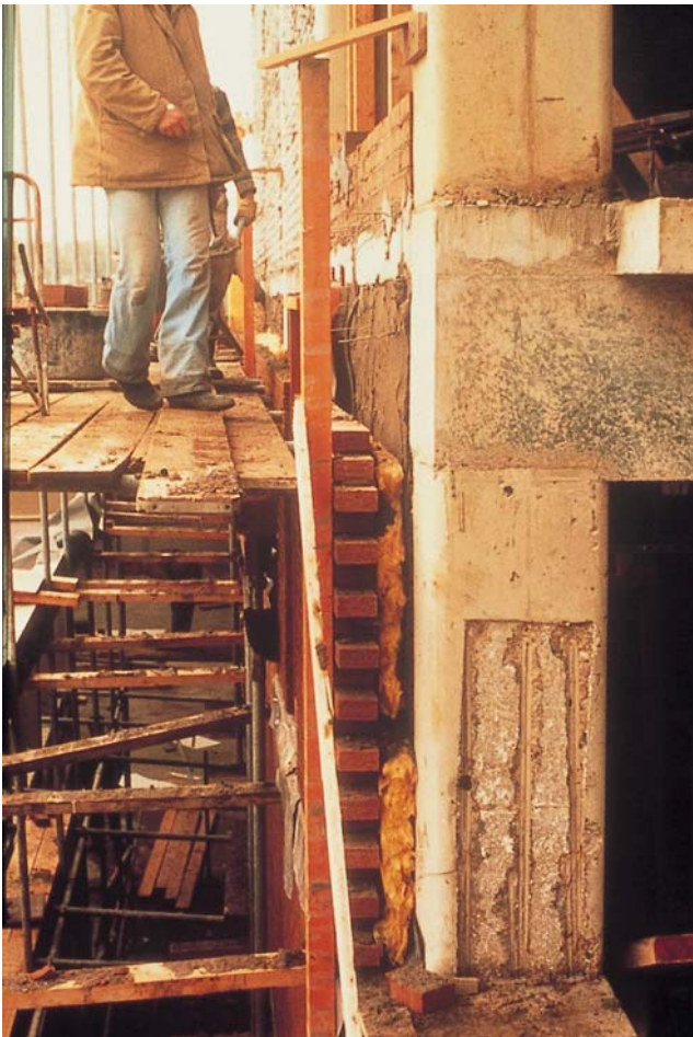
figuur 6. de kwaliteit van isoleren laat soms sterk te wensen over
