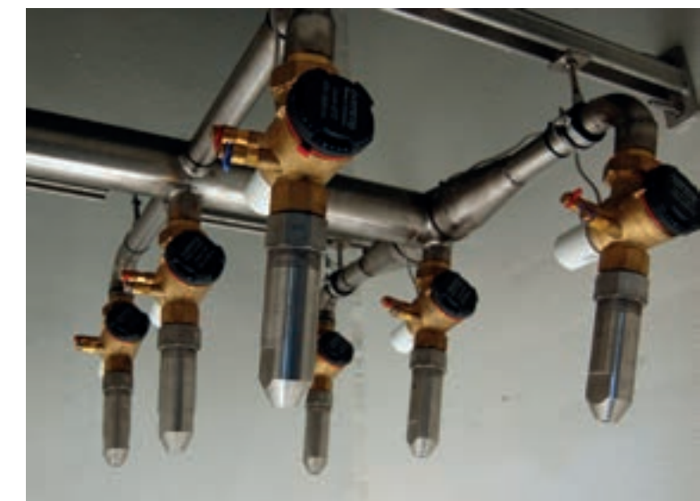
De sproeiers van de klimaatcascade die bijdraagt aan de ventilatie van Hotel Breeze. De druppels die hieruit komen, brengen al vallend een luchtstroming op gang.
