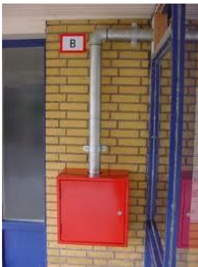
Figuur 26: Aansluitkast en -punt DBL
