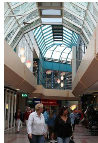
Figuur 3: Rook- en warmteafvoervoorzieningen in overdekte winkelstraten.
