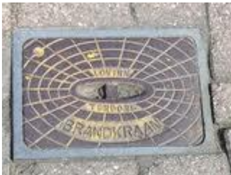
Figuur 27: Ondergrondse hydrant en met opzetstuk.
