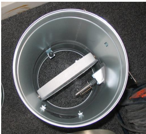
Figuur 25: Binnenzijde brandklep (in geopende toestand). In geval van brand zal de klep sluiten en wordt het kanaal afgedicht.
