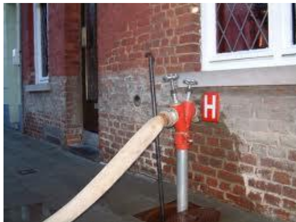
Figuur 27: Ondergrondse hydrant en met opzetstuk.
