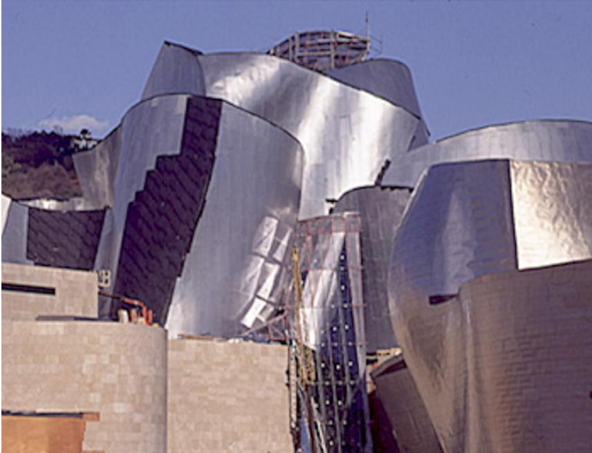
Figuur 39 Dit gebouw reflecteert directzonlicht. Dit kan verblinding opleveren
