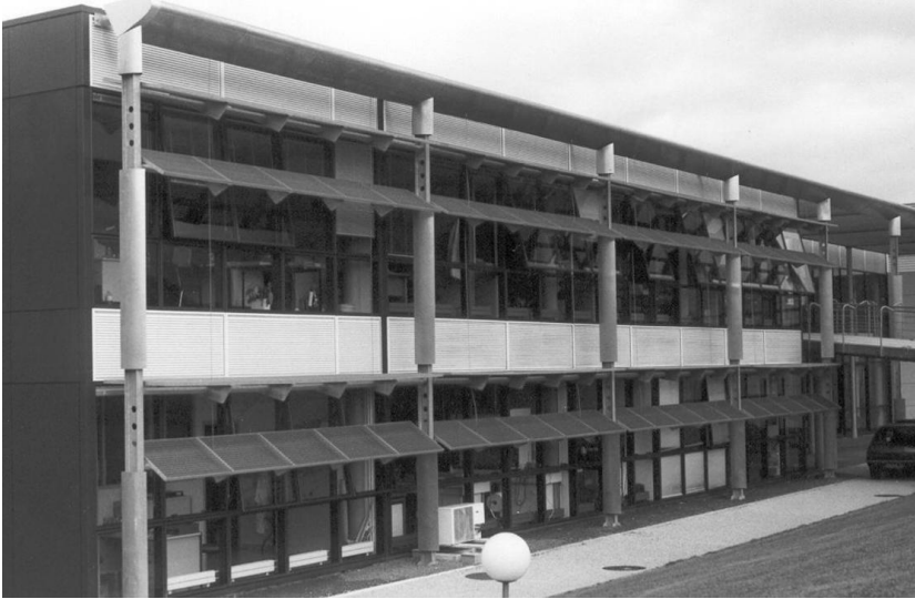
Figuur 38 Luifels aan een gebouw zorgen met name voor zonwering
