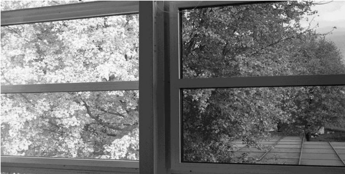
Figuur 31 Regelbare beglazing: bruikbaar als helderheidswering. De LTA links is 60% en rechts 18%
