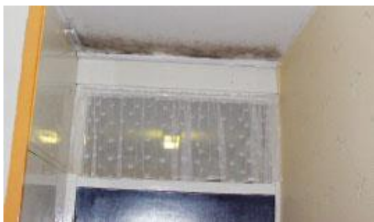
Schimmelaantasting op kritische locaties in de woningschil.
