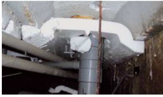
Rondom leidingdoorvoeren en kruipluiken treden veel lucht lekkages op.
