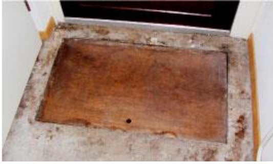
Rondom leidingdoorvoeren en kruipluiken treden veel lucht lekkages op.
