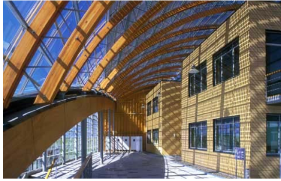
Figuur: Het atrium van een kantoorgebouw van de ECN in Petten wordt door natuurlijke ventilatie (thermische trek) geventileerd en gekoeld.
