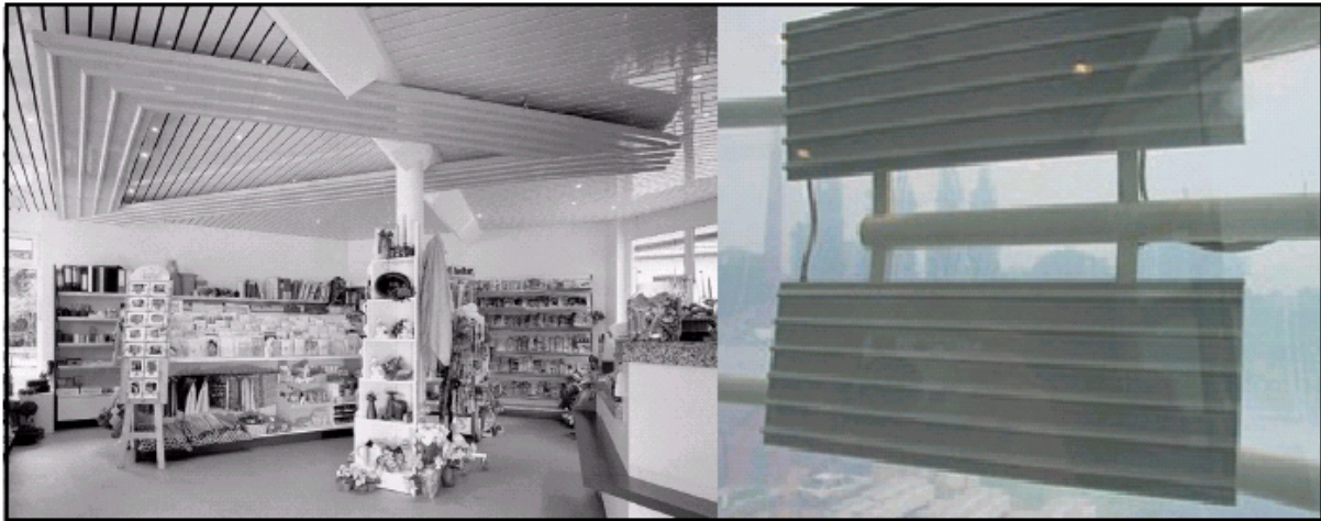
figuur 10 toepassing van stralingspanelen in een winkel en in het National Space Centre in Leicester
