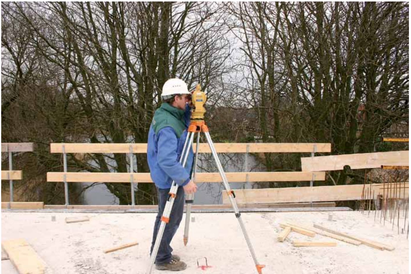
Maatvoering met total station.
