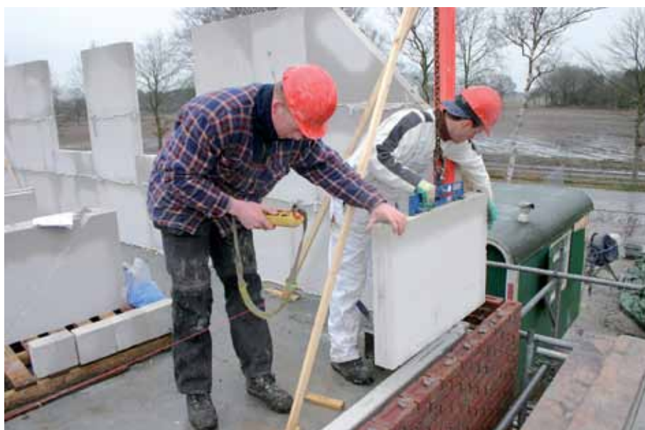
Stapelbouw met kalkzandsteen.
