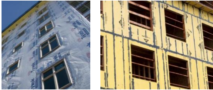
Figuur 3 en 4 : Het aanbrengen van het membraam volgens 3 en 4 in de praktijk
