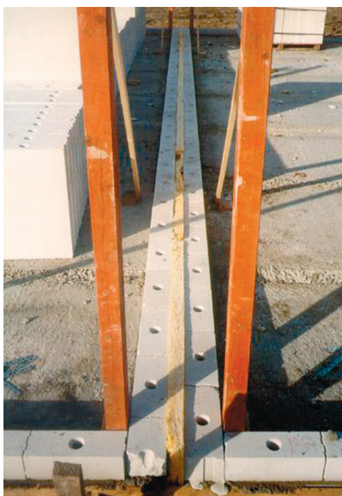
Correct aangebrachte isolatie ter plaatse van de ankerloze bouwmuur.
