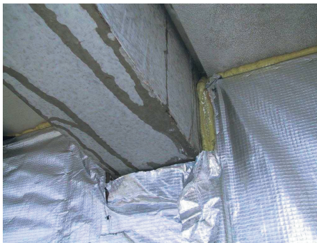
Het verloop van hemelwater tijdens de uitvoering. De naden zijn aan de bovenzijde nog niet afgekit. Daarnaast heeft de console geen opgezette rand en waterhol. Gevolg: het hemelwater loopt naar het binnenspouwblad toe.
