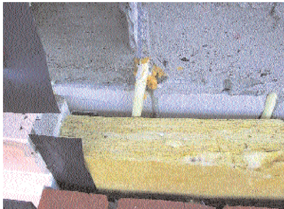
1) Door elektraleidingen in de spouw ontstaat convectiestroom en vermindering van de warmteweerstand.
