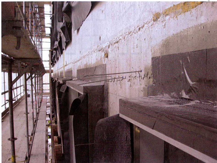
Voor luchtdichtheidsklasse 3 geldt: 'waar mogelijk de aansluitingen afplakken'. Foto: Adviesburo Nieman.
