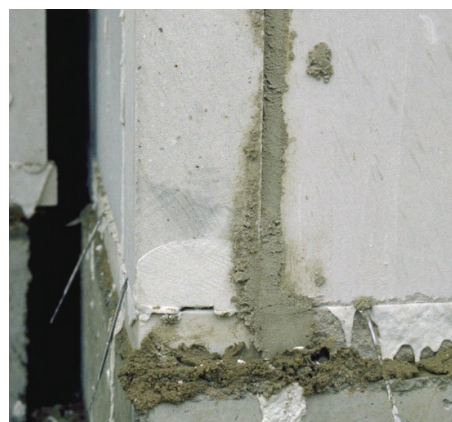
Bij gietbouw en stapelbouw de hoekverbinding goed dichtmetselen.
