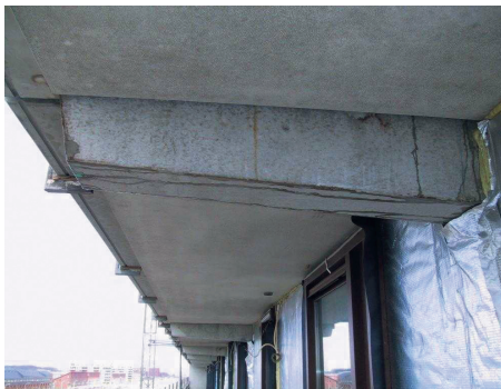
Het verloop van hemelwater tijdens de uitvoering. De naden zijn aan de bovenzijde nog niet afgekit. Daarnaast heeft de console geen opgezette rand en waterhol. Gevolg: het hemelwater loopt naar het binnenspouwblad toe.
