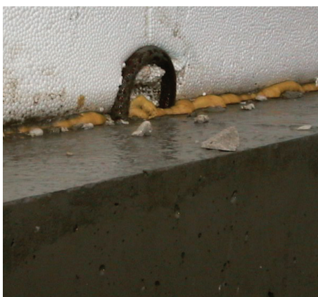
Afdichting van de aansluiting van de begane grondvloer op de fundering met behulp van pur-schuim.
