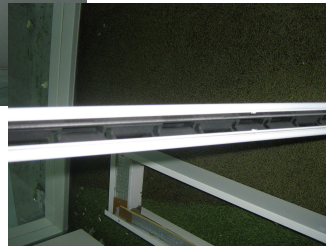
Open luchtarmaturen afdichten
