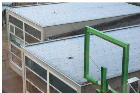
figuur 6-3 Het gevolg van het aanbrengen van bevestigingsmiddelen: doorbreking van de thermische isolatie (dus extra warmteverlies)
