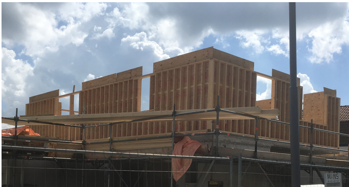
Figuur 6-5 Houtskeletbouwconstructie
