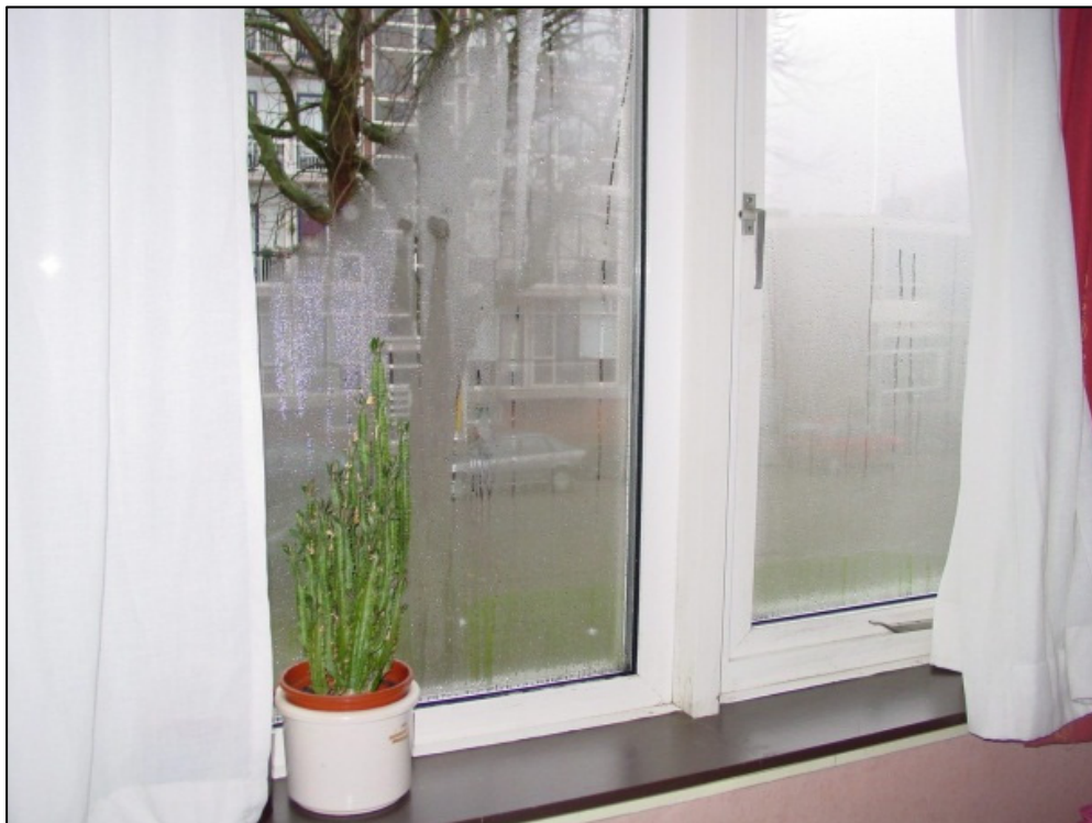
figuur 8-5 Oppervlaktecondensatie op de binnenzijde van dubbele beglazing
