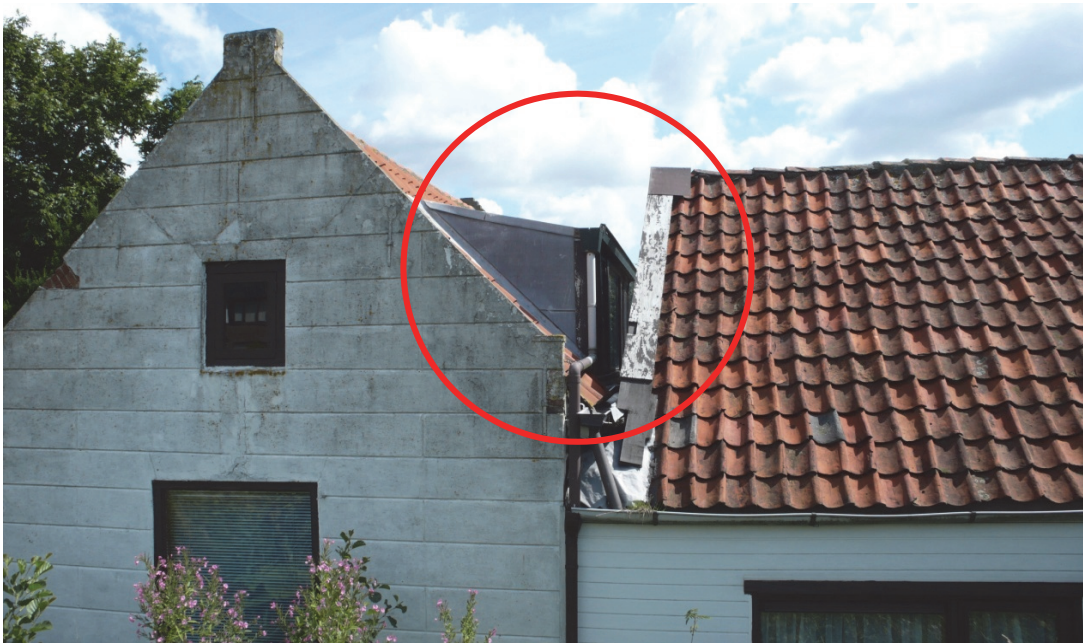
Figuur 3-7 Belemmering ter plaatse van dakkapel ten gevolge van een bouwwerk gelegen op eigen perceel.
