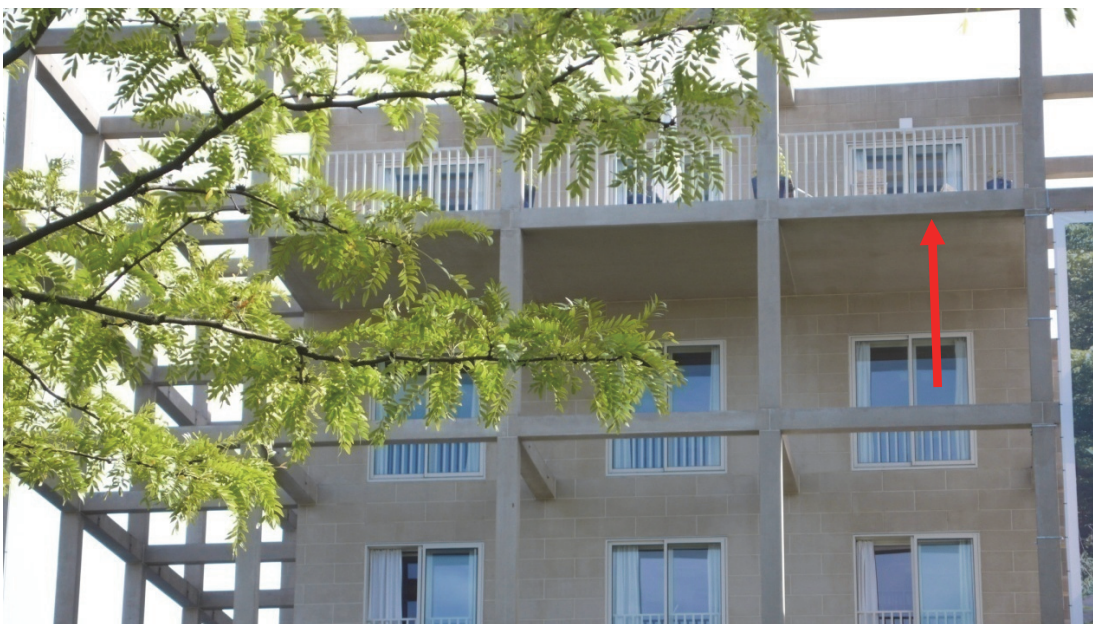
Figuur 3-8 Belemmering door een overstek.
