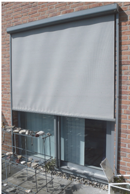
Figuur 3-3 Zonwering die regelbaar is wordt niet in rekening gebracht bij de bepaling van de doorlaat.
