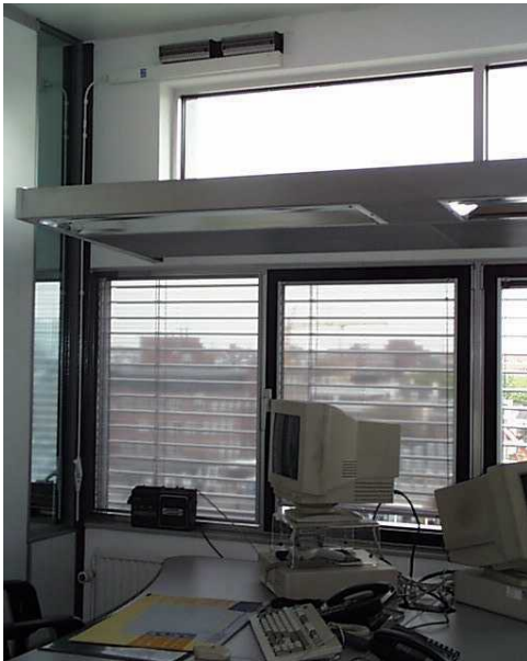
figuur 2. de "lichtplank" kaatst het licht tegen het plafond waardoor het achter in het vertrek terechtkomt; het onderste deel van het raam heeft een lichtwering, waardoor de lichtverdeling over het vertrek meer gelijkmatig wordt
