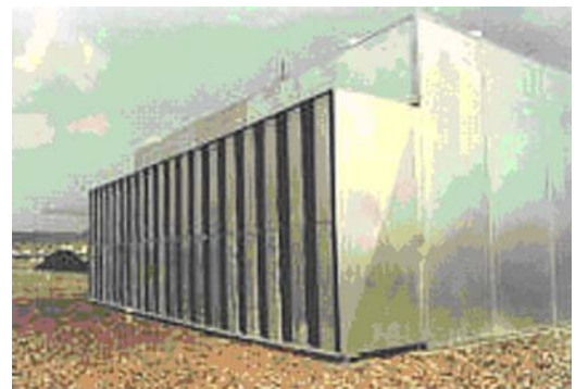
Figuur 4.20. Ronde geluiddempers voor kleine en coulissendempers voor grote luchtbehandelingsystemen.
