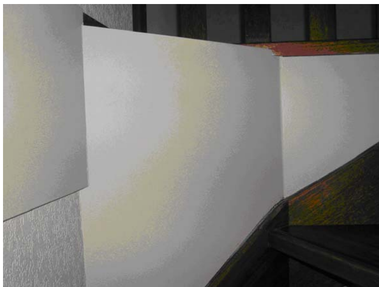
Figuur 4.6. Houten beplating op stijl- en regelwerk als afwerking of lambrizing werkt als een laagfrequent absorber (paneelconstructie).
