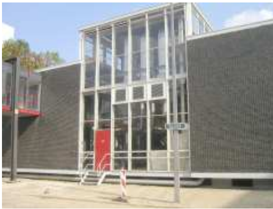
Figuur 1.5. Voorbeeld van een vlakbron (Ketelhuis TU/e).
