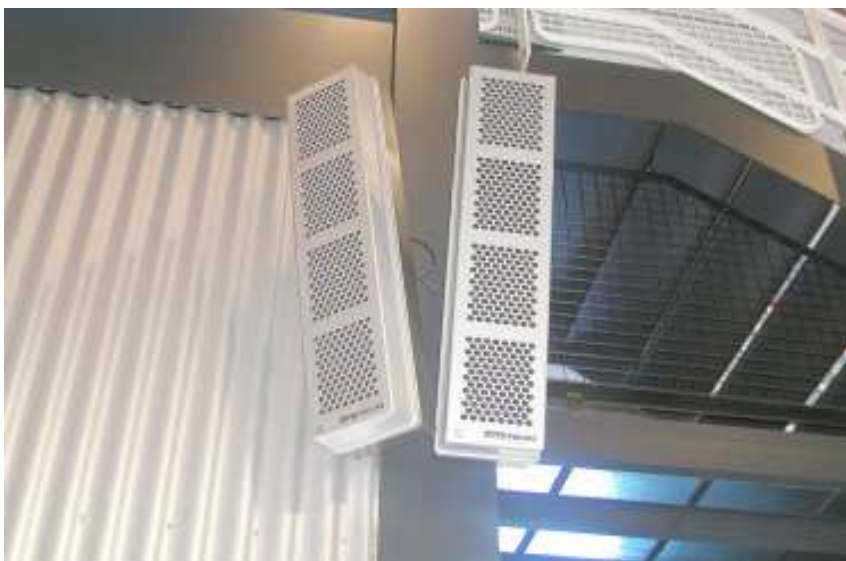
Figuur 1.20. Geluidinstallatie bedoeld voor spraak.
