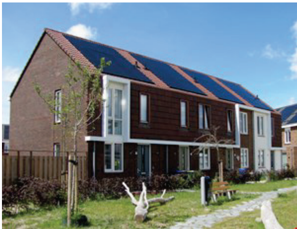
Afb. 3.4 Voorbeeld van energieneutrale en nul-op-de-meter woningen: het project De tuinen van Sion in Rijswijk (ZH) met 32 laagbouwoningen (6 twee-onder-één-kapwoningen en 26 rijtjeswoningen). De woningen zijn voorzien van o.a. driefvoudige beglazing, een combi-warmtepomp met warmte-koudeopslag in de bodem, vloerverwarming/koeling, gebalanceerde ventilatie met WTW en CO 2 -regeling met meerdere zones, douche-WTW en bijna 20 m 2 PV-panelen. Vijf woningen zijn voorzien van extra PV-panelen waardoor ze het niveau 'nul-op-de-meter' bereiken; bovendien zijn aan de bewoners zeer energiezuinige huishoudelijke apparatuur meegeleverd. De eerste werkelijke energieverbruikscijfers (2013-2014) geven aan dat deze vijf woningen aan de verwachtingen qua energieverbruik voldoen (Betrokken partijen: adviesbureau Merosch; architect: Inbo; opdrachtgever: Gemeente Rijswijk; aannemer/ontwikkeling Dura Vermeer; realisatie: 2013)
