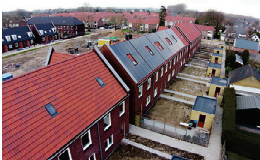
Afb. 3.6 Voorbeeld van Energie-nota-nul-woningen: de vijf 'energienotaloze' woningen in het project Maurikse Gaarden in Maurik voldoen hieraan. De woningen zijn naar het oosten en westen gericht, zodat ook de beide schuine dakvlakken een oost- en west-oriëntatie hebben. Hierop liggen in totaal ruim 50 m 2 PV-panelen. De EPC bedraagt -0,3. De woningen zijn naast de PV-panelen ook voorzien van o.a. drievoudige beglazing, HR-combiketel en een ventilatiesysteem met natuurlijke toevoer en mechanische afvoer. Er is aan de bewoners een energieprestatiegarantie voor 10 jaar door de ontwikkelaar afgegeven. (Betrokken partijen: architect: AGS Arnhem; bouwer/ontwikkelaar: Trebbe; opdrachtgever: Stichting Woningbeheer Betuwe; realisatie: 2013. Foto's: Trebbe)
