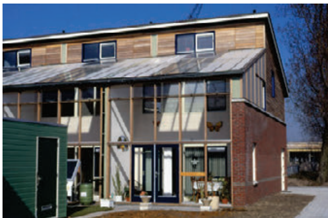
Afb. 4.17 Serres bij huurwoningen in Banne-Oost in Amsterdam-Noord. Het dak van de serre is deels voorzien van (doorzichtige) beglazing in verband met daglichttoetreding. Op het dak zijn ook zonnecollectoren aangebracht. (Betrokken partijen: ontwerp: Tjerk Reijenga, voorheen BEAR Architecten, Gouda. Realisatie: 1995)
