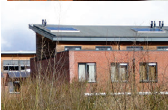
Afb. 9.20 Verschillende voorbeelden van individuele zonneboilers, in Delft (boven) en Boxtel (de Zonnegolven, (Betrokken partijen: architect: Tjerk Reijenga, HBG))
