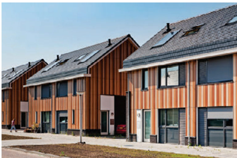
Afb. 3.7 Het project Velve-Linden in Enschede bestaat uit ruim 210 woningen, waarvan 82 houtskeletbouw 'passiefhuizen' (met Passiefhuis-certificaat en EPC = 0,36). De woningen zijn voorzien van o.a. een zeer goede warmte-isolatie, HR-combiketel en zonneboiler, CO 2 gestuurde gebalanceerde ventilatie met WTW en zomernachtventilatie (zie de roosters op de
