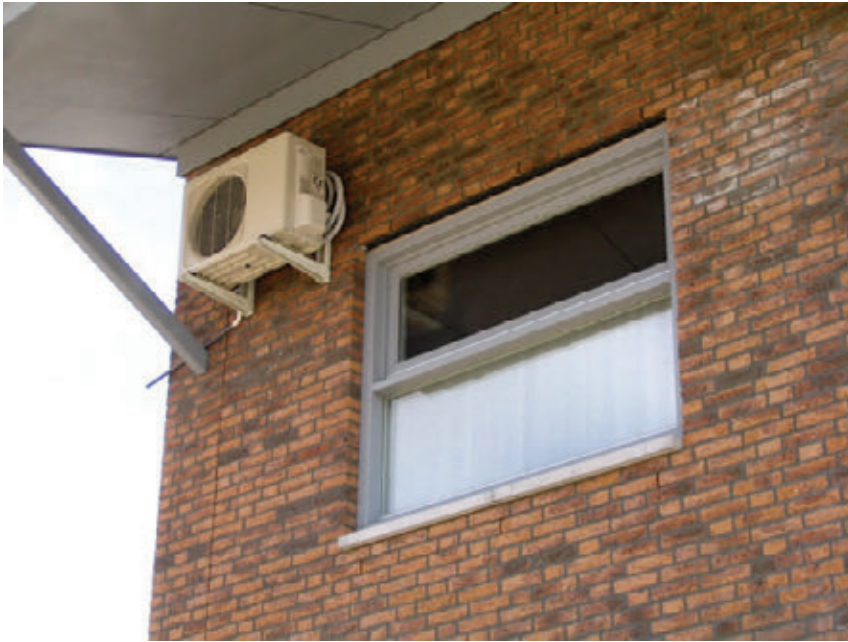
Afb. 8.4 Een split-unit heeft een tocht risico en ontsiert de gevel
