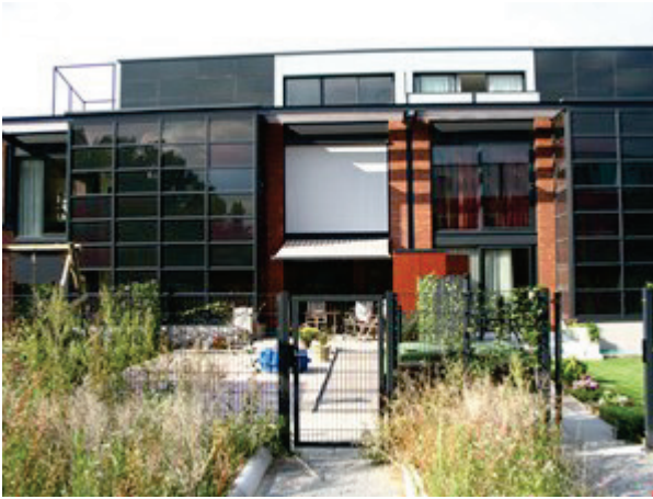
Afb. 5.35 Voorbeeld van een project waarbij de beweegbare zonwering bij de koopprijs inbegrepen was. Een deel van de gevel is voorzien van doorzicht-PV-panelen, ook een vorm van zonwering. De woningen liggen in De Energiewijk in Roomburg te Leiden. (Betrokken partijen: Planontwikkeling: Gemeente Leiden; Architect: Han van Zwieten Architecten bna; Ontwikkelaar/aannemer: ACL; Aannemingscombinatie Leiderdorp; Realisatie 2004)
