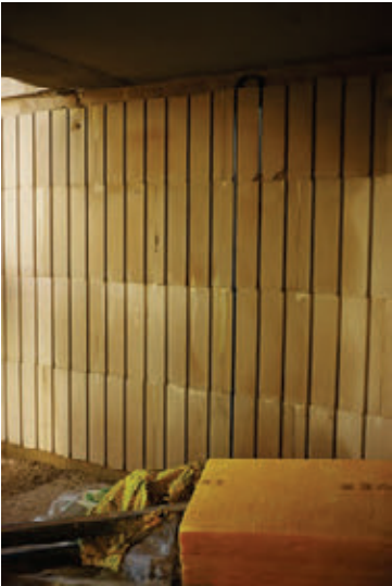
Afb. 7.9 Warmtewand in aanbouw. De prefab sleuven kunnen zowel verticaal als horizontaal lopen, dit hangt af van het merk van de elementen. Horizontaal lopende leidingen hebben als voordeel dat ze eenvoudiger te ontluchten zijn; nadeel is dat de stenen qua draagkracht (door de horizontale sleuven) niet optimaal gebruikt worden
