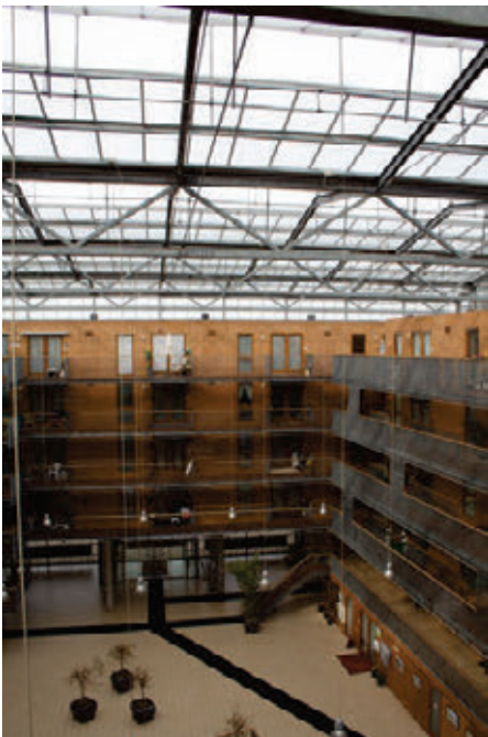
Afb. 4.18 Het Woongebouw Emerald te Delfgauw met honderden elf woningen, heeft een centraal atrium en is bedoeld voor senioren. De verbreding van de galerijen bij de woningentree nodigt uit tot sociaal contact. Het glazen dak is afkomstig uit de kassenbouw.
