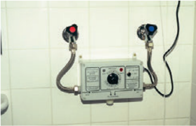
Afb. 9.5 Voorschakelkastje bij hot-fillaansluiting voor een standaard wasmachine
