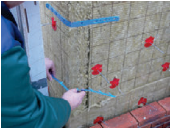
Afb. 5.21 Kunststof strip (of hoekanker) om zachte isolatieplaten bij uitwendige hoeken zorgvuldig op elkaar te laten aansluiten. (Bron: Gebroeders Bodegraven BV)
