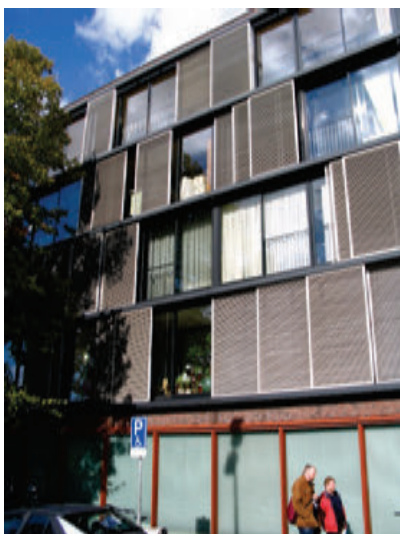
Afb. 4.11 Jalozeiluiken of schuifschermen: één van de vele mogelijkheden voor zonwering. De lamellen kunnen zowel vast als draaibaar zijn, afhankelijk van het lameltype en fabricaat. Op de foto het project Delfts Blauw in Delft met luiken opgebouwd uit een frame en lamellen van aluminium; (Betrokken partijen: Limelight; architectenbureau: Architecten Cie en ontwikkelaar Eurowoningen)
