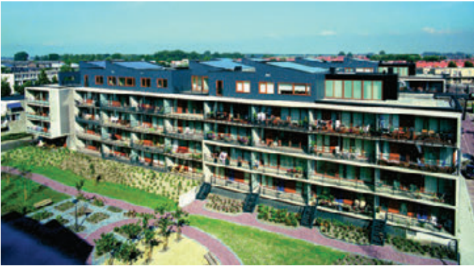
Afb. 9.22 Een collectief zonneboilersysteem op appartementencomplex Charivarius te Haarlem. Een project van Eco Energy en Pré Wonen Haarlem; (Betrokken partijen: aannemer: Panagro; architect: HMADP groep; adviseur: BOOM-S/I; Realisatie 2005; Eneco)
