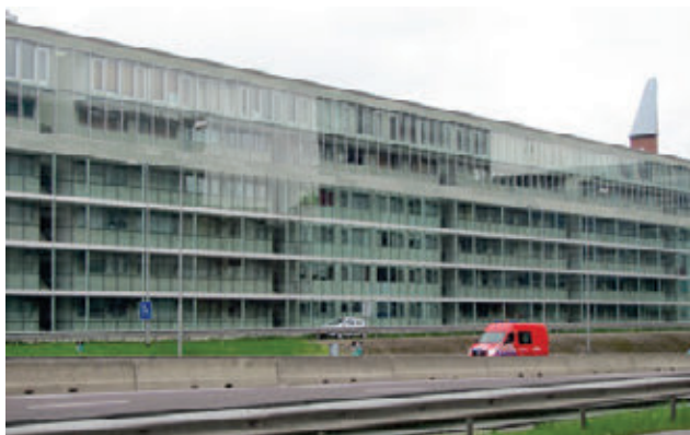
Afb. 4.16 Renovatie en nieuwbouwproject De Leeuw van Vlaanderen met 72 huurwoningen voorzien van nieuwe vliesgevel als geluidbuffer. Om geluid en stank van het verkeer op de A10 (Amsterdam) te weren is de vliesgevel geplaatst voor de bestaande oostgevel. De ruimte achter deze vliesgevel dient voor de ontsluiting van de woningen en wordt geventileerd met schone buitenlucht afkomstig van de westgevel. Vanwege de brandveiligheid is de verglaasde ruimte voorzien van een stuwkrachtventilatie om bij brand rook te verspreiden en te verdunnen (Betrokken partijen: Nieman Raadgevende Ingenieurs, opdrachtgever: Far West, architect Heren 5 architecten, aannemer Coen Hagedoorn, realisatie 2005)
