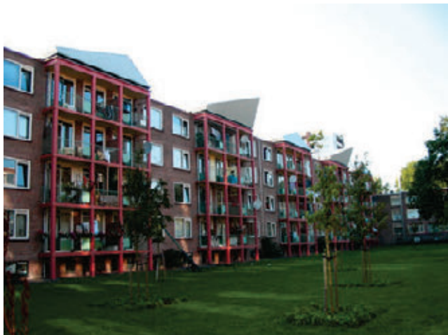
Afb. 7.31 In het 2MW-project in het Haarlemse stadsdeel Schalkwijk wordt bij 382 bestaande flatwoningen door toepassing van verschillende systemen en maatregelen een energiebesparing gehaald van 70%. Een nooit eerder op zo'n grote schaal toegepaste combinatie van zonnecollectoren, warmteopslag in de bodem en warmtepompen vervangt de bestaande verwarmingsinstallatie. De zonnecollectoren zijn in duidelijk zichtbare 'dakkappen' opgenomen. (Betrokken partijen: Opdrachtgevers: Elan Wonen Haarlem, de Woonmaatschappij en Pré Wonen; energiesysteem: Eneco; adviseur: BOOM-SI en DWA)
