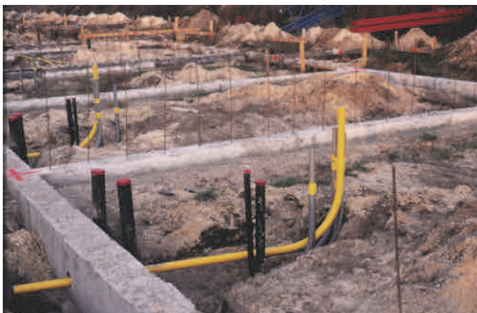
Afb. 5.10 Op tal van nieuwbouwlocaties wordt zonder kruipruimte gebouwd. Op de foto een voorbeeld van bouwen zonder kruipruimte van op de Vinx-locatie Nieuwland in Amersfoort
