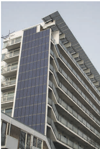
Afb. 10.7 In het duurzame renovatieproject Torenflat Bieslandsekade van Woonbron Delft zijn gelijk met de renovatie 260 m 2 PV-panelen geplaatst. De PV-panelen zijn geïntegreerd in de gevel, het dak én in balkons. De PV-panelen op het dak doen ook dienst als zonwering en de PV-panelen in de balkons zorgen tegelijk voor privacy. De zonnestroom die wordt opgewekt verzorgt bijna alle collectieve installaties in het tien verdiepingen hoge gebouw, zoals liften, verlichting en mechanische ventilatie. (Betrokken partijen: Opdrachtgever: Woonbron, Architect: Van Schagen architecten, PV engineering en installatie: BST, Elektron, advies: W/E-adviseurs. Realisatie: 2003)
