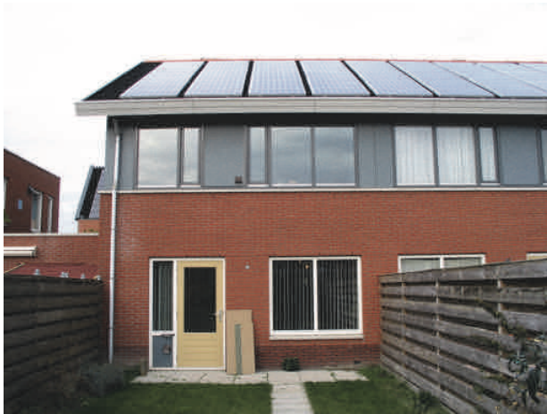
Afb. 10.6 PV-panelen in het dak geïntegreerd in het meet- en demonstratieproject in de 'Stad van de Zon' op de HAL-locatie (Heerhugowaard, Alkmaar, Langedijk) van VBM. Per woning is PV met 3.600 Wp vermogen aangebracht. De gemeten opbrengst bedraagt circa 3.400 kWh per jaar. Voor het toegepaste type dak is de Dakaward 2004 toegekend. (Betrokken partijen: Ontwerp: BBHD Architecten, ontwikkeling: VBM (VosAlkmaar), projectleider: Willem Koppen, aannemer: Heddes Bouw, fabrikant PV: BP-Solar. Realisatie 2003)
