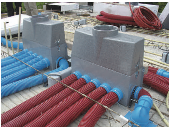
Afb. 6.4 Twee luchtverdeelkasten bij een gebalanceerd ventilatiesysteem, de ene voor de toevoerlucht (met de blauwe kanalen), de andere voor de afvoerlucht (met de rode kanalen). In de verdeelkast worden de luchthoeveelheden ingeregeld. Dit heeft als voordeel dat men niet-regelbare ventielen voor toe- en afvoer gebruikt die dus niet ontregeld kunnen worden bij bijv. het schoonmaken door bewoners. In de verdeelkasten, die deels in de (beton)vloer aangebracht zijn, kunnen geluiddempers worden ingebouwd. De verdeelkasten moeten bereikbaar blijven voor inspectie en onderhoud. (Bron: Burgerhout BV)
