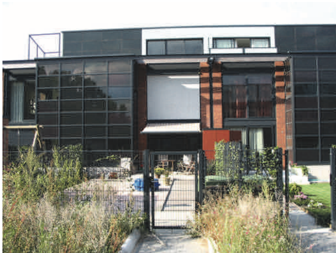
Afb. 5.35 Voorbeeld van een project waarbij de beweegbare zonwering bij de koopprijs inbegrepen was. Een deel van de gevel is voorzien van doorzicht-PV-panelen, ook een vorm van zonwering. De woningen liggen in De Energiewijk in Roomburg te Leiden. (Betrokken partijen: Planontwikkeling: Gemeente Leiden; Architect: Han van Zwieten Architecten bna; Ontwikkelaar/aannemer: ACL; Aannemingscombinatie Leiderdorp; Realisatie 2004)
