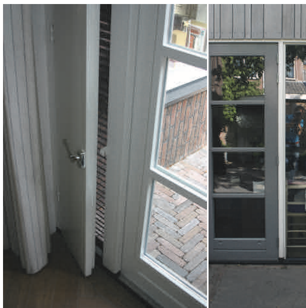
Afb. 6.22 Voorbeeld van een voorziening voor zomernachtkoeling in een woning te Zeist. In de gevel van de woonkamer zijn 2 inbraakvrije ventilatieroosters ( 2 \times 0,25 \times 2 \text{ m} = 1 \text{ m}^2 ) met een isolatieluis aangebracht; een dakraam zorgt voor een goede natuurlijke trek. (Betrokken partijen: Architect ii studio, realisatie Ettekoven Annemer & interieurbouwer, advies BOOM-SI; realisatie 2009. Foto's: Joost Ettekoven)
