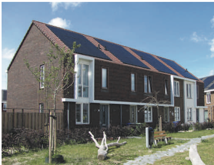
Afb. 3.5 Voorbeeld van energieneutrale en nul-op-de-meter woningen: het project De tuinen van Sion in Rijswijk (ZH) met 32 laagbouwoningen (6 twee-onder-één-kapwoningen en 26 rijtjeswoningen). De EPC van de energieneutrale tussenwoningen bedraagt circa -0,11. De woningen zijn voorzien van o.a. driedubbele beglazing, een combi-warmtepomp met warmte-koudeopslag in de bodem, vloerverwarming/koeling, gebalanceerde ventilatie met WTW en CO 2 -regeling met meerdere zones, douche-WTW en bijna 20 m 2 PV-panelen. Vijf woningen zijn voorzien van extra PV-panelen waardoor ze het niveau 'nul-op-de-meter' bereiken; bovendien zijn aan de bewoners zeer energiezuinige huishoudelijke apparatuur meegeleverd. De eerste werkelijke energieverbruikscijfers (2013-2014) geven aan dat deze vijf woningen aan de verwachtingen qua energieverbruik voldoen (Betrokken partijen: adviesbureau Merosch; architect: Inbo; opdrachtgever: Gemeente Rijswijk; aannemer/ontwikkeling Dura Vermeer; realisatie: 2013)
