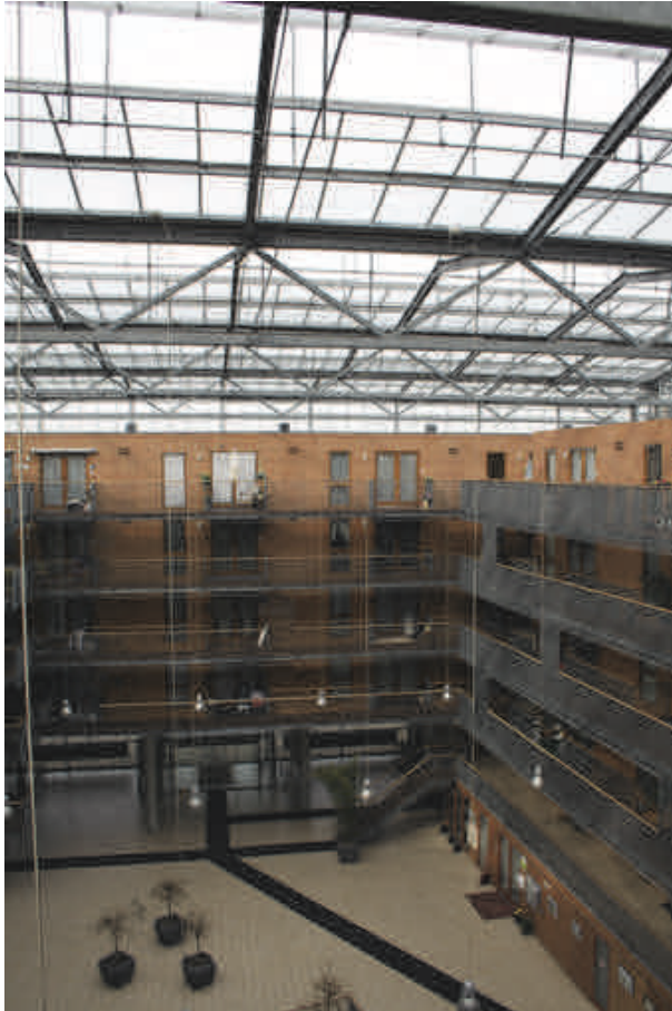
Afb. 4.18 Het Woongebouw Emerald te Delfgauw met honderdenelf woningen, heeft een centraal atrium en is bedoeld voor senioren. De verbreding van de galerijen bij de woningentree nodigt uit tot sociaal contact. Het glazen dak is afkomstig uit de kassenbouw. (Betrokken partijen: Initiatief Woningcorporatie Vestia Delft, architect: Kees Christiaanse Architects & Planners, uitvoering: Bouwcombinatie Delfgauw. Realisatie 2001)
