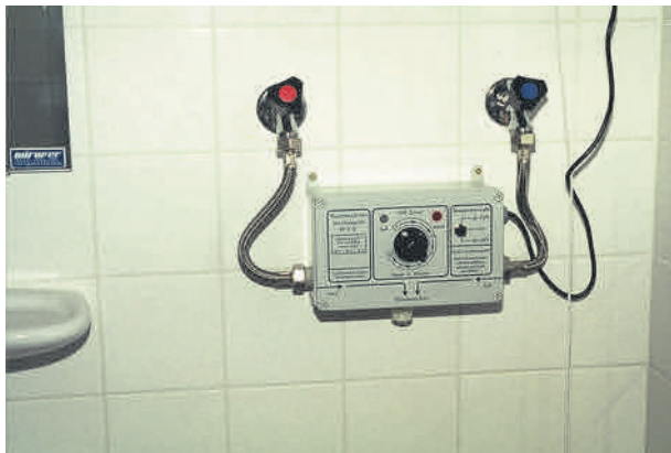
Afb. 9.5 Voorschakelkastje bij hot-fillaansluiting voor een standaard wasmachine
