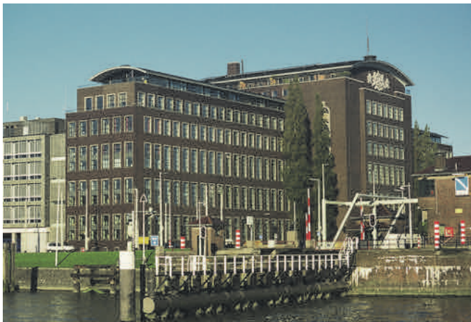
Afb. 7.37 Project Puntegale, het voormalige Rotterdamse belastingkantoor, is een multifunctioneel woon/werkcomplex [167]. Het complex is o.a. voorzien van collectieve installaties voor ruimte- en tapwaterverwarming. Het is aangesloten op een warmtenet en heeft bovendien een zonneboiler- en een mini-wkk. Alle (woon)eenheden zijn aangesloten op een gebouwbeheersysteem. Via infrarood-detectie worden in de betreffende woning de verwarming en ventilatie op gebruiks- of (bij afwezigheid) op minimum-niveau gebracht. De bewoner kan de gebruikstemperatuur drie graden hoger of lager instellen. Per eenheid wordt het gas-, elektriciteits- en waterverbruik (warm en koudwater) ingelezen en centraal geregistreerd. (Betrokken partijen: Opdrachtgever: Stadswonen; Architect: De Jong Bokstijn architecten; Aannemer: Moeskop's Bouwbedrijf)
