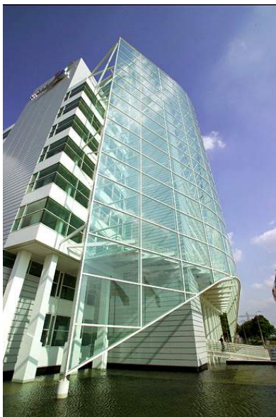
figuur 4: voorbeeld 2 e huidgevels; een inmiddels klassiek voorbeeld met een lage g-waarde van 0,12 is de tweede huidgevel van het ING-hoofdkantoor in Amsterdam (rechts), hier zijn reflecterende lamellen toegepast en is voldoende ventilatie opening aanwezig.
