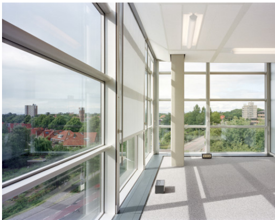
figuur 3 voorbeeld vereenvoudigde klimaatgevel (Mercatorgebouw in Nijmegen); het werkingsprincipe is rechts aangegeven.
