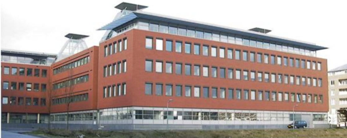
figuur 6 voorbeeld zonneschoorstenen in een rijkskantorengedrag op het Ceramique-terrein in Maastricht; er is ook natuurlijke toevoer via de gevel toegepast
