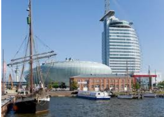
figuur 8 in het Klimahaus in Bremerhaven wordt de energiezuinige DEC-koeling toegepast
