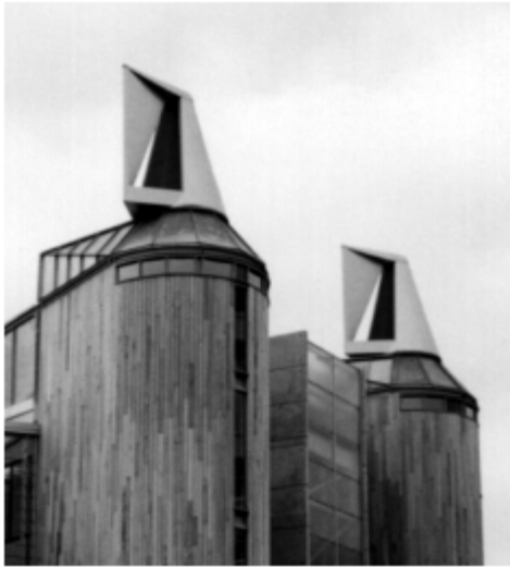
figuur 3 windvaan of “gek”; de kappen draaien met de windrichting mee zodat er altijd onderdruk heerst
