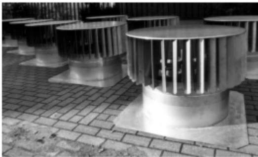
figuur 4 deze ventilatiekappen zijn ongevoelig voor de windrichting
