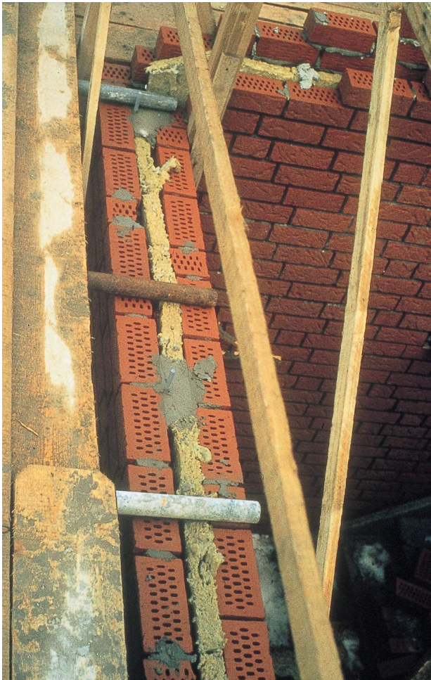
figuur 8. niet direct de meest geschikte wijze om isolatiemateriaal op zijn plaats te houden!
