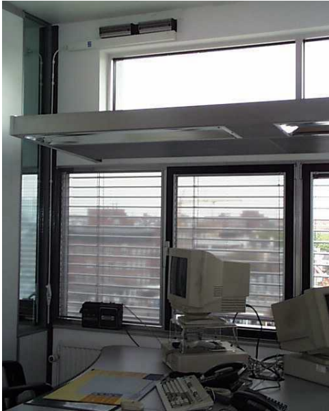
figuur 2. de "lichtplank" kaatst het licht tegen het plafond waardoor het achter in het vertrek terechtkomt; het onderste deel van het raam heeft een lichtwering, waardoor de lichtverdeling over het vertrek meer gelijkmatig wordt
