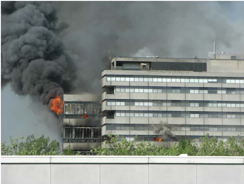
Figuur 1. Brand in het gebouw van de faculteit Bouwkunde van de TU Delft.
